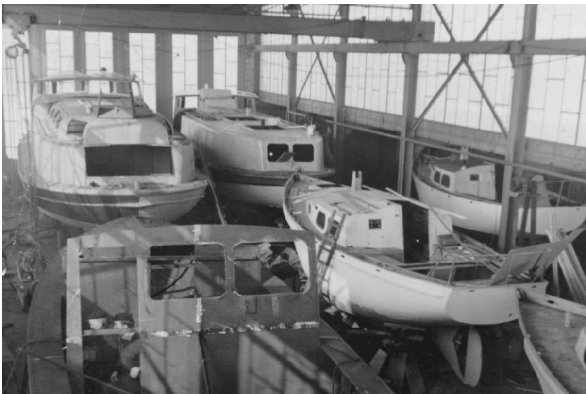
Vol interieur van de bouwhal aan de Nijverheidstraat met zes schepen in aanbouw rond 1964. Twee parlevinkers, drie Lemstra kiel-middenzwaard-zeiljachten en op de voorgrond een werkvlet.
